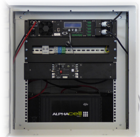
AtrOX 55-650 incl. optional UATS and Thermostat
